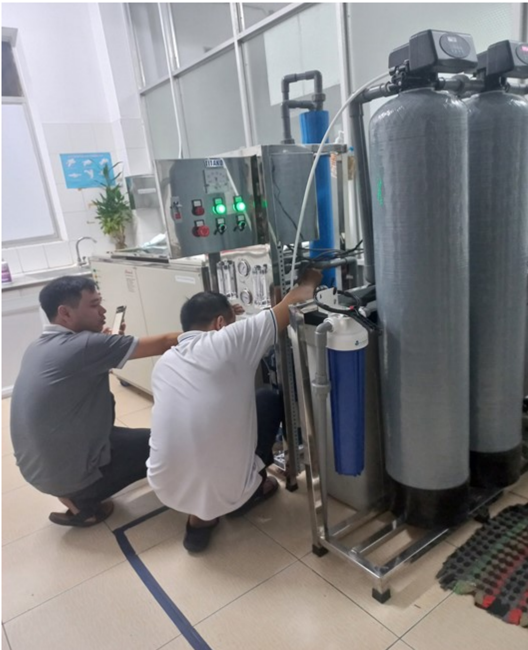
Kỹ sư đang thi công hệ thống
