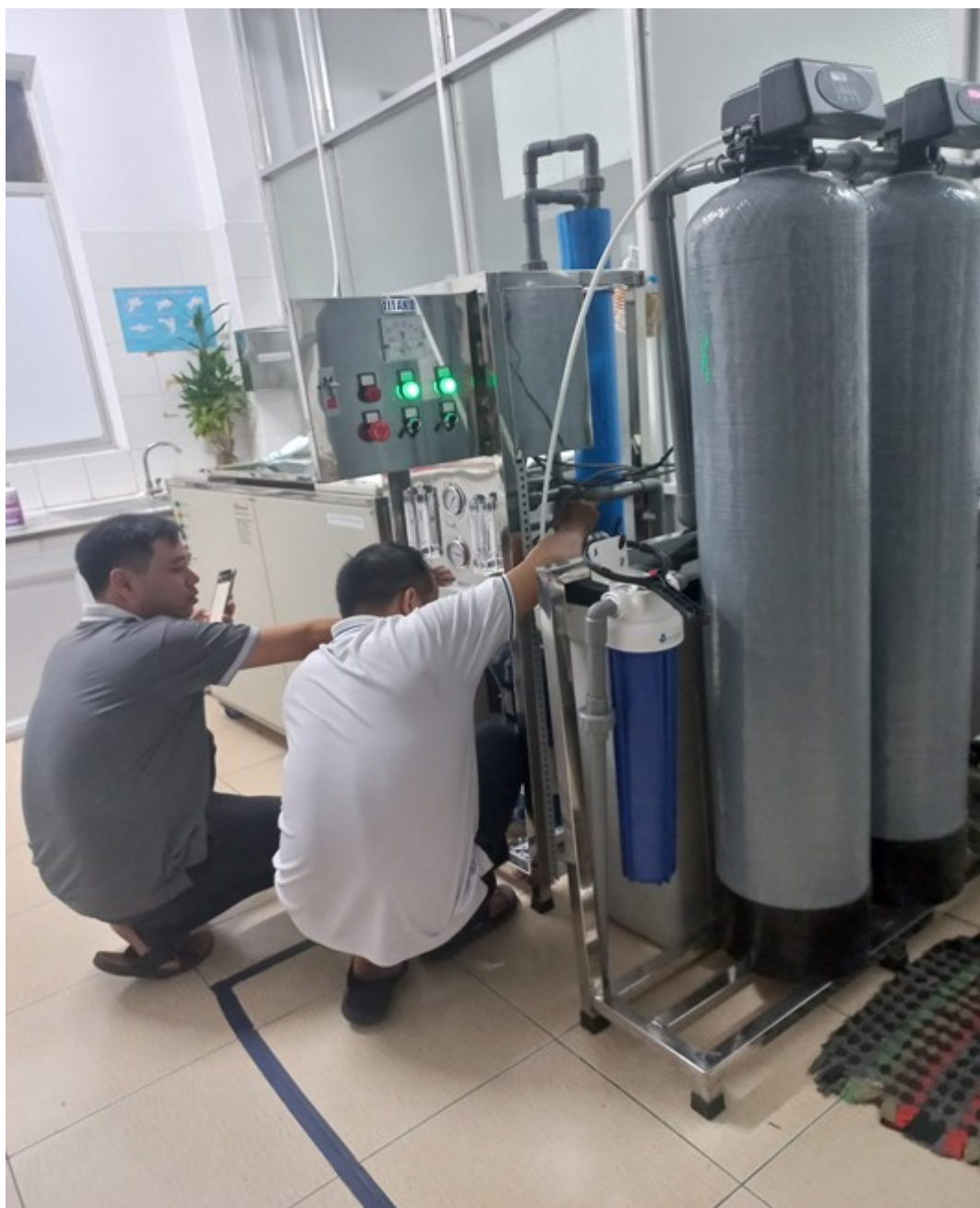
Kỹ sư đang thi công hệ thống
